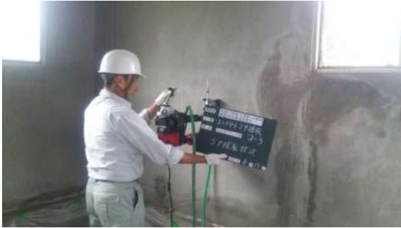
構造物のコア抜き作業
