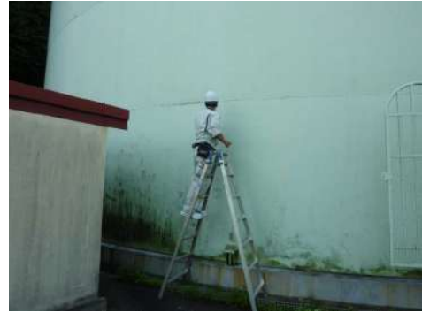
目視・打音点検状況
