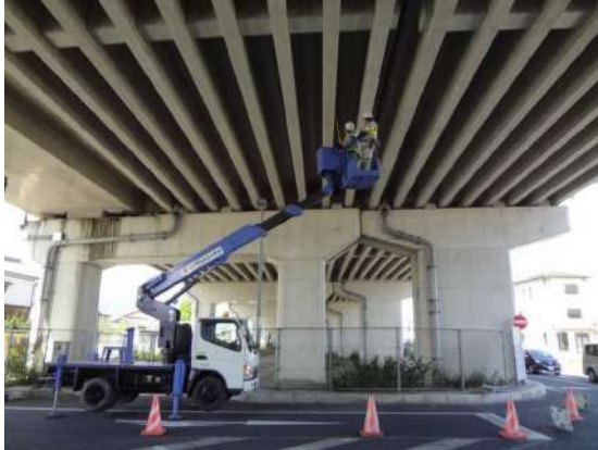
高所作業車による高架橋点検
