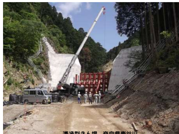
透過型えん堤 奈良県妻谷川 (弊社設計、施工中写真)
