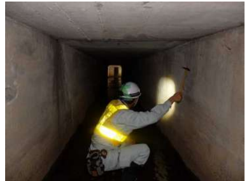
打音点検状況
