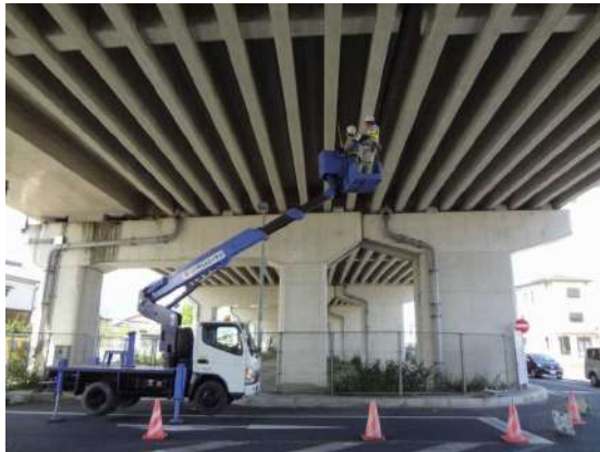
高所作業車による高架橋点検
