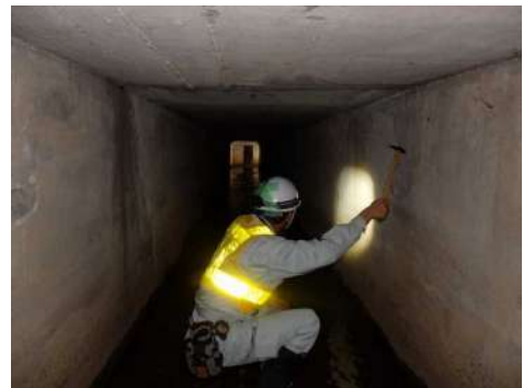
打音点検状況
