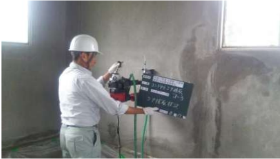
構造物のコア抜き作業
