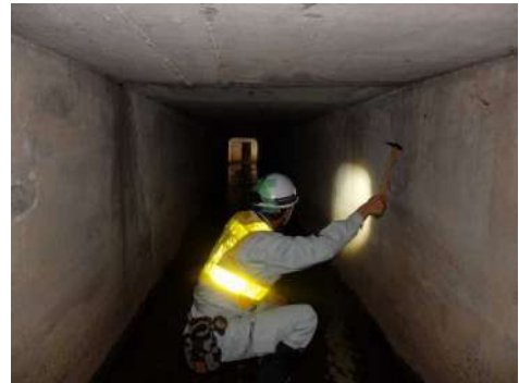
打音点検状況
