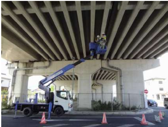
高所作業車による高架橋点検
