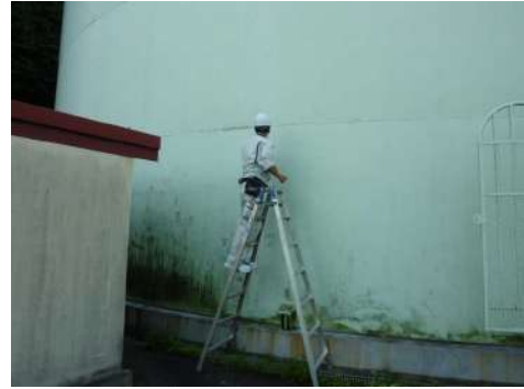
目視・打音点検状況
