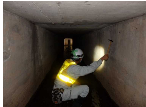
打音点検状況
