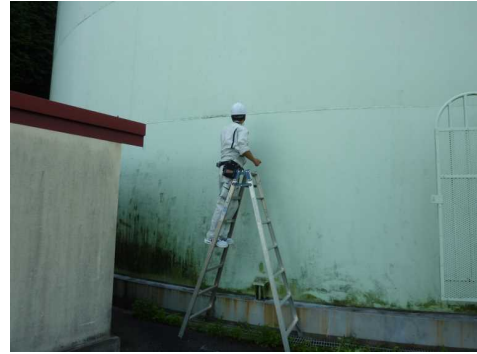
目視・打音点検状況
