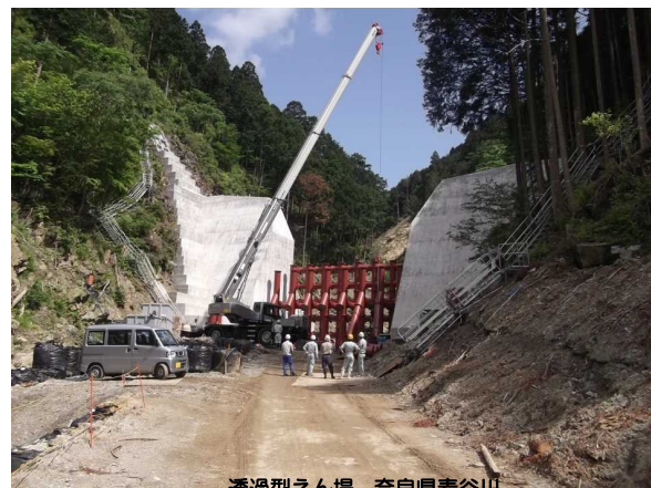
透過型えん堤 奈良県麦谷川 (弊社設計、施工中写真)
