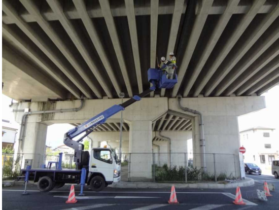
高所作業車による高架橋点検
