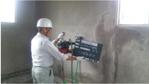
構造物のコア抜き作業
